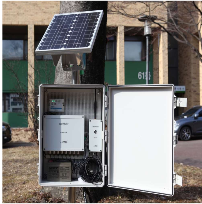
태양열 발전 시스템 (30W, 인산철 배터리)
